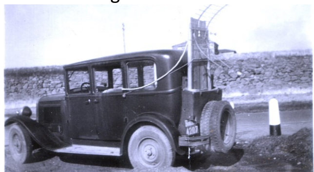
L'auto per gli esperimenti di RADIOTELEFONIA MOBILE - si noti la parabola sul retro. Santa Marinella – Via Aurelia sullo sfondo il casale Alibrandi 20 luglio 1930
