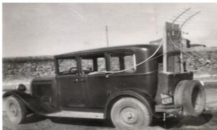
*La mitica Balilla a 3 marce usata da Marconi per gli esperimenti di radiotelegrafia mobile e Radio localizzazione, sul retro è installata l'antenna parabolica.*
